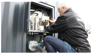
Grâce au panneau « Quick Connect » qui simplifie le raccordement des tuyaux et des câbles, la centrale est rapide à mettre en service pratiquement n'importe où dans l'entreprise.
